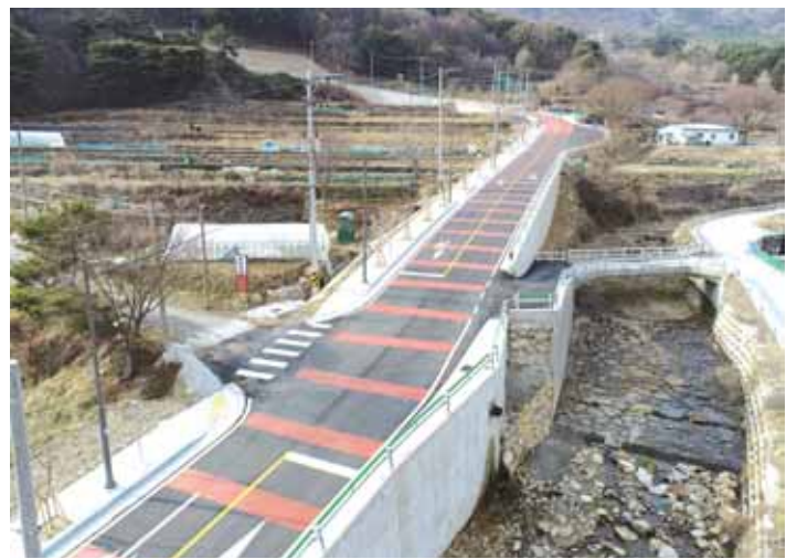
▼가창 우록 동회관~백록 도시계획도로 개설공사_구간 일부
