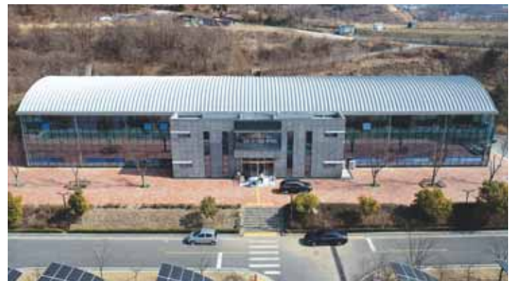
다목적체육관리모델링 공사 후
