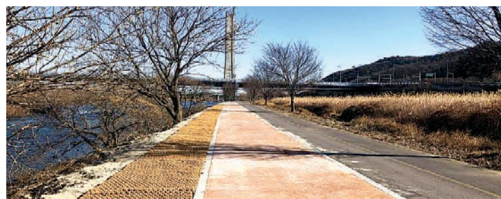
금호강 자전거도로(정비 후)
