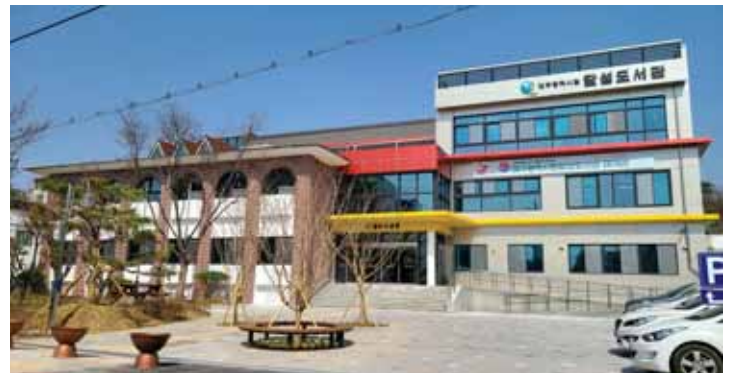
리모델링 후 달성도서관전경
