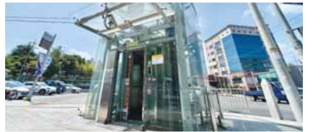
대구도시철도 전 역사 외부 엘리베이터 에어컨 설치
