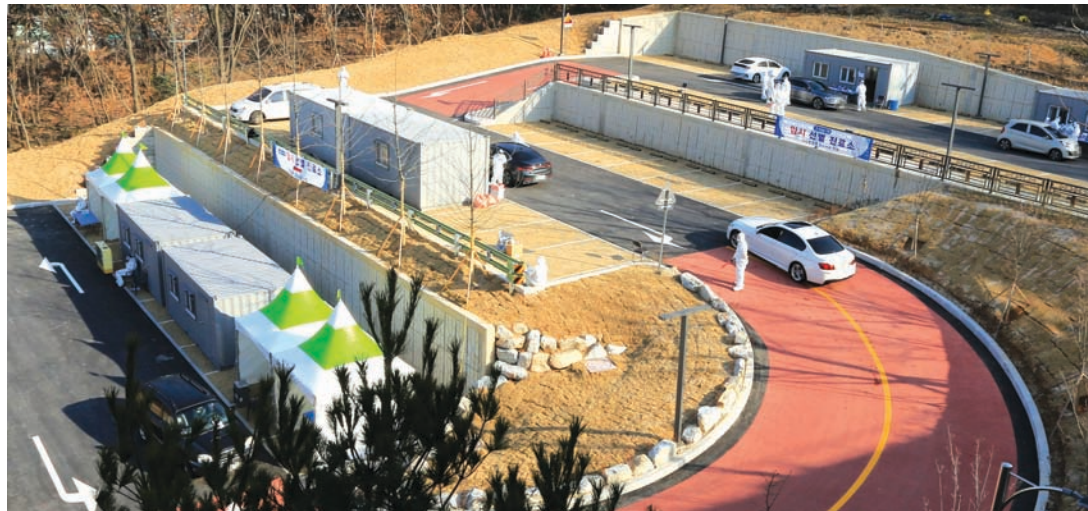
달서구노인종합복지관 옆 공영주차장 임시 선별진료소
