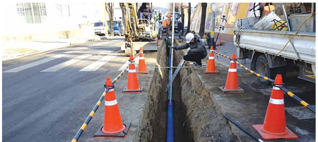
상수도 현대화사업 공사
